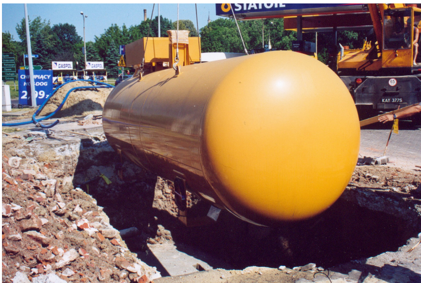
Czy ta powłoka na zbiorniku wytrzyma zakładane w projekcie 30 lat bez ochrony katodowej?
