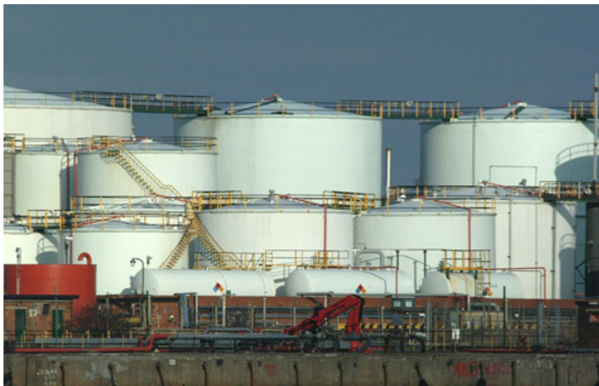
W zbiornikach magazynowych podwójne dno ma nieco większy sens, ale i tak konieczne jest zastosowanie zabezpieczenia w postaci odpowiednio dobranych powłok ochronnych od strony surowej ropy.
