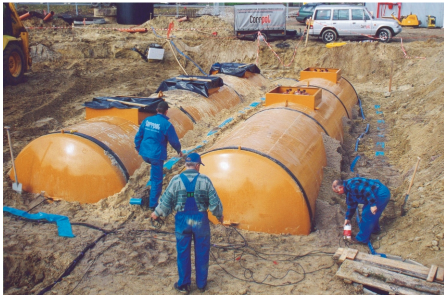
Instalacja ochrony katodowej nowych zbiorników jest stosunkowo prosta i tania, jeśli prace zsynchronizowane są z zabudową zbiorników
